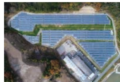
たつのメガソーラー発電所
